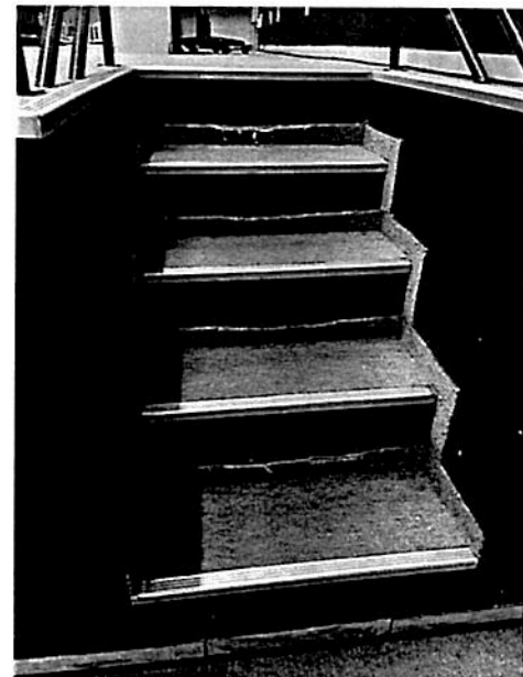
Figura 12: descolamento de carpete (baixo estado de conservação).
