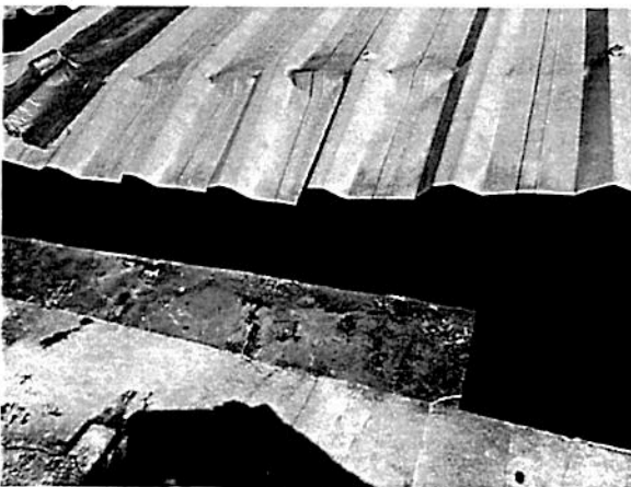
Figura 7: telhas danificadas.
