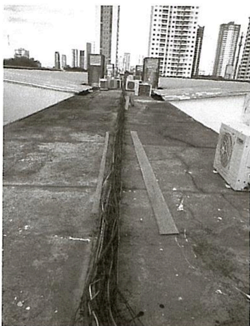
Fotos 26 e 27: Sistema de distribuição de energia elétrica para ar condicionados em desconformidade com a NBR 5410.
