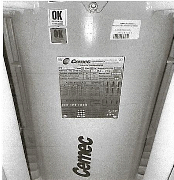
Foto 06 e 07: Detalhes do transformador a óleo da subestação de energia elétrica.
